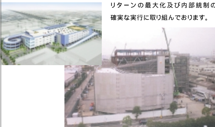
来年4月完成をめざして順調に工事が進む三郷ロジスティックセンター(仮称)
